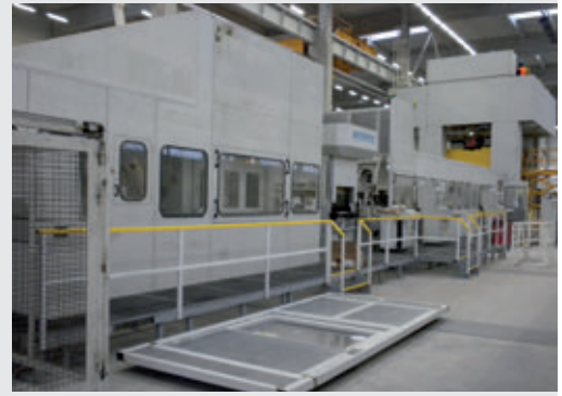
Die neue Platinenschneidanlage wird in Senica installiert.
