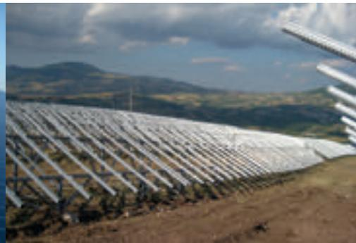
MetalSistem verwendet Magnelis® auf seinen modularen Stahlkonstruktionen für Photovoltaikanlagen.
