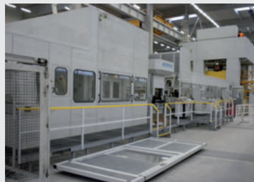
Nouvelle ligne de découpage en cours d'installation à Senica.
