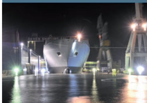
Le Karel Doorman en construction au chantier Damen de Galati (avec l'aimable autorisation de Damen)
