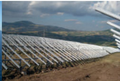
MetalSistem utilise Magnelis® pour ses structures modulaires en acier destinées aux systèmes photovoltaïques.
