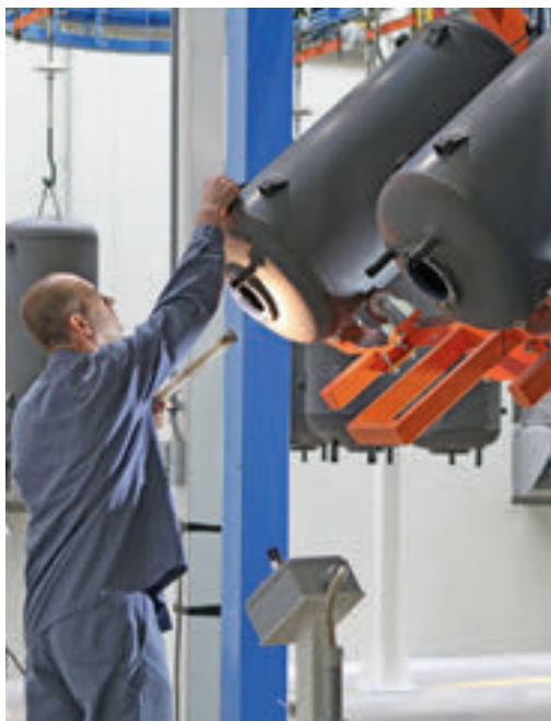
Ispezione visiva dell'interno dei boiler prima dell'applicazione della cassa esterna
