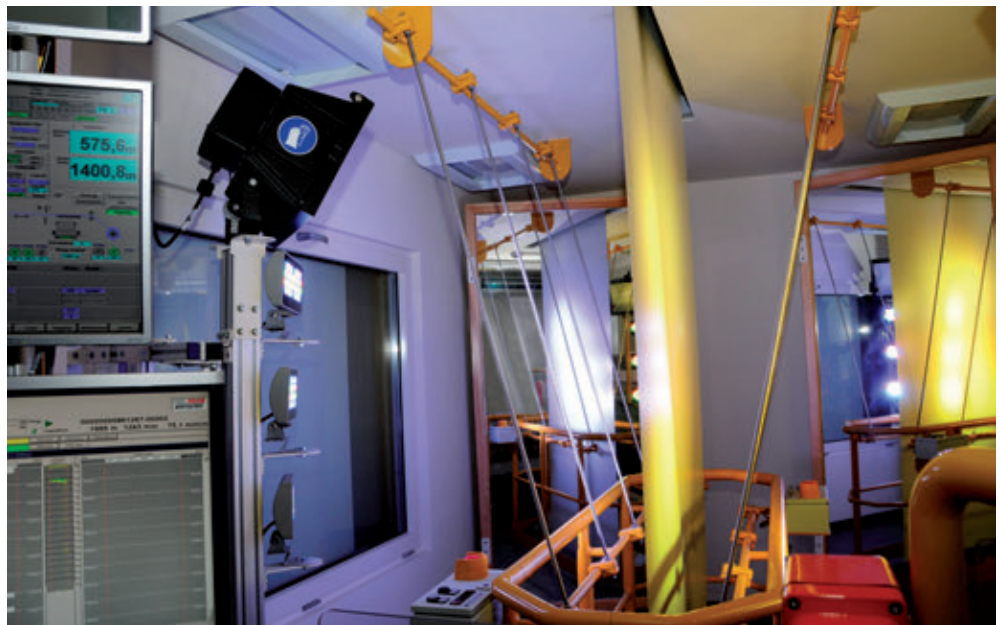
De inspectiecabine van de organische bekledingslijn in Eisenhüttenstadt zorgt voor een oppervlakkwaliteit die overeenkomstig Europese benchmarkniveaus voor huishoudtoestellen is.
