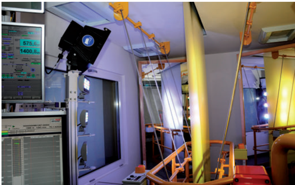
Stanowisko inspekcyjne linii powlekania organicznego w Eisenhüttenstadt zapewnia urządzeniom AGD jakość powierzchni zgodną ze standardami europejskimi.
