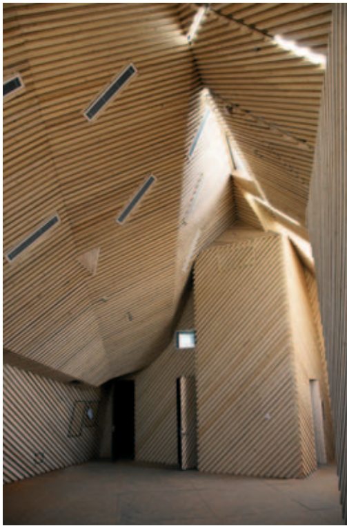
Des châssis en acier maintiennent en place les panneaux intérieurs en épicea.
