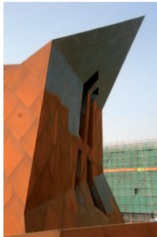
L'acciaio Indaten® esterno è sottoposto a un trattamento di ossidazione
