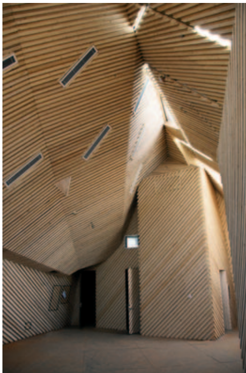
I pannelli in legno sono mantenuti in sede dai telai in acciaio
