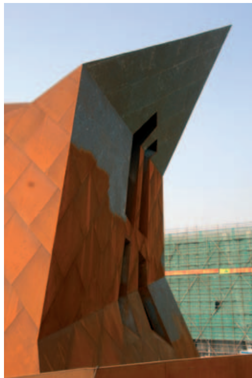
Oțelul patinat situat la partea exterioră este supus tratamentului de oxidare
