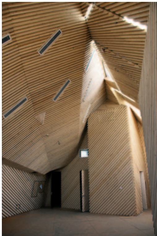
Cadre din oțel susțin panourile interioare din lemn
