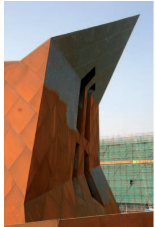
El acero Indaten® utilizado en exteriores recibe un tratamiento de oxidación
