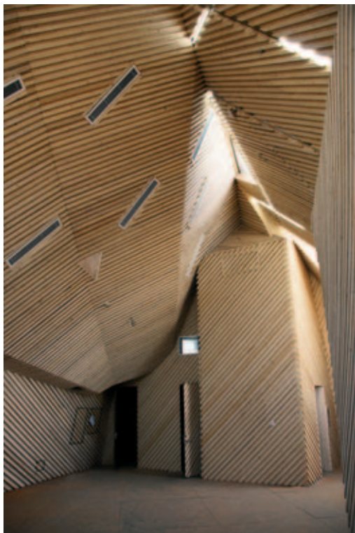
Wewnętrzne panele drewniane osadzone są w stalowych ramach
