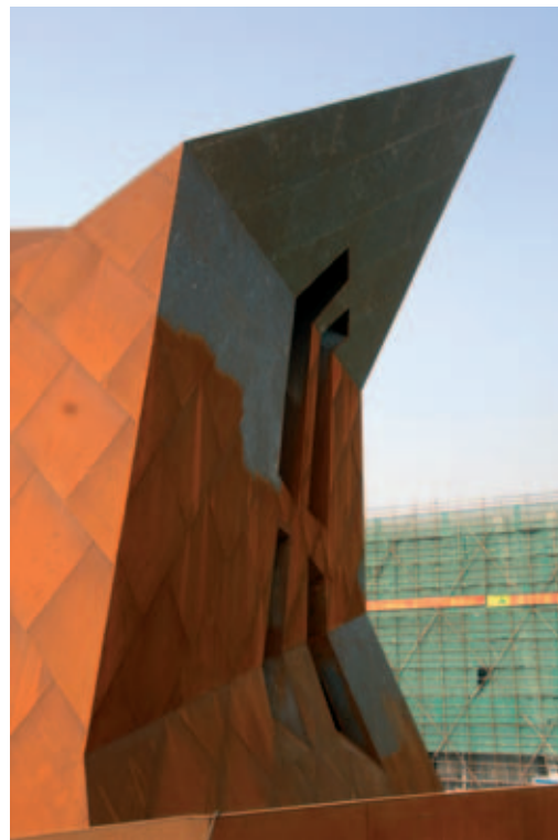
Stal kortenowa wykorzystywana na zewnątrz budynków poddawana jest procesowi oksydacji
