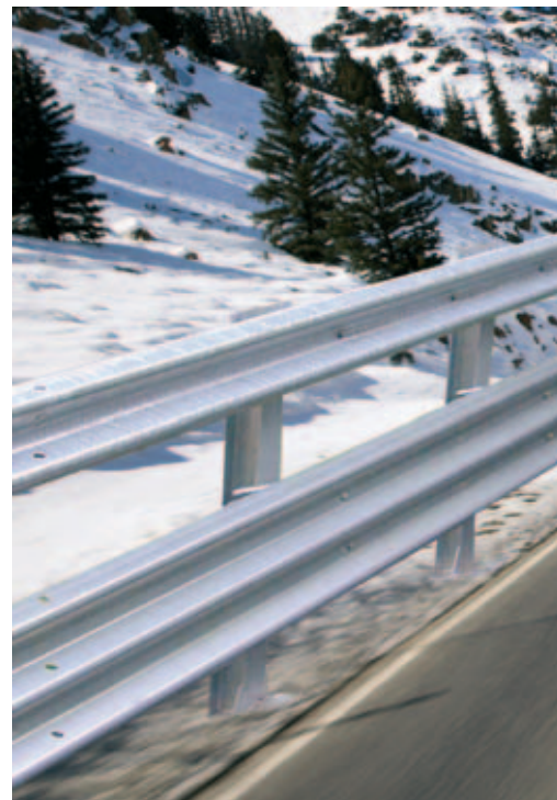
Magnelis® to innowacyjna, przyjazna środowisku powłoka metaliczna zapewniająca ochronę przed korozją w najbardziej wymagających środowiskach
