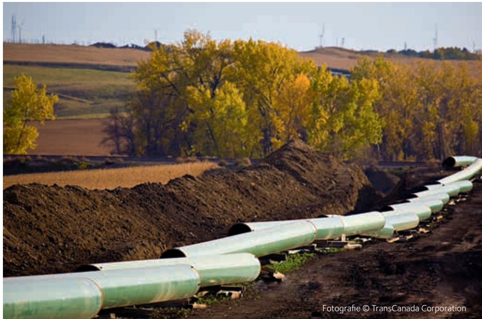
Trubky pro transkanadský ropovod Keystone připravené k pokládce.
