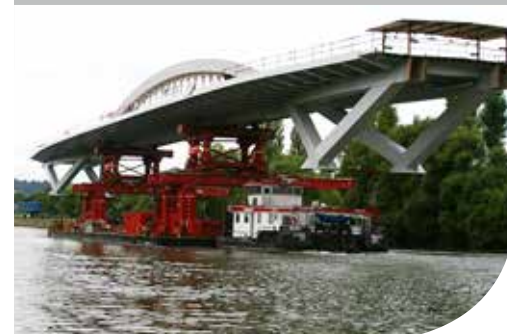
Transport středového pole mostu nákladní lodí po řece Moselle.
