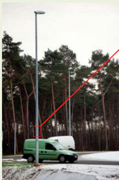
Sloup ZIPpole® je navržen tak, aby se při nárazu rozevřel jako 'zip'
