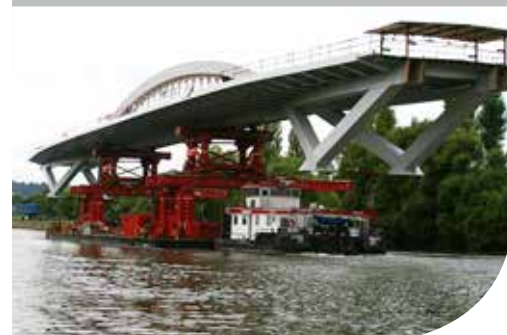
Transport des Hauptfeldes der Brücke per Leichter entlang der Mosel.
