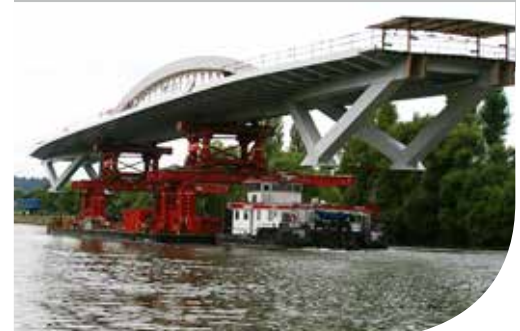
Transporte del vano central del puente en gabarra por el río Mosela.
