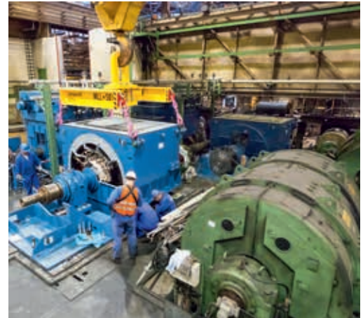
Montaje del nuevo motor síncrono para el tren tándem de bandas en frío (izquierda) y motor antiguo de corriente continua (derecha).
