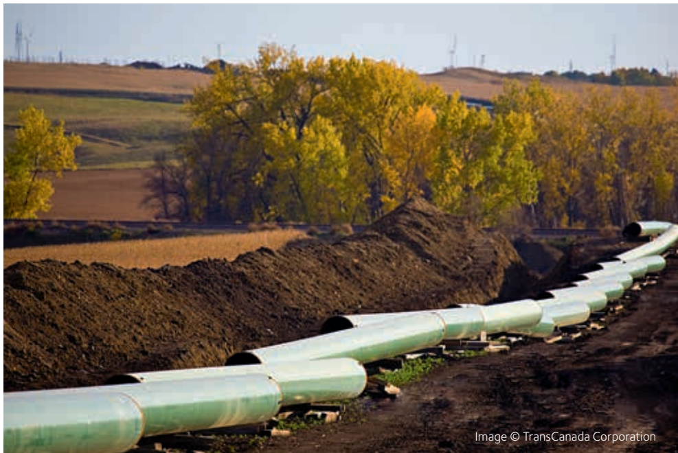
Pose de tubes pour l'oléoduc Keystone de TransCanada.
