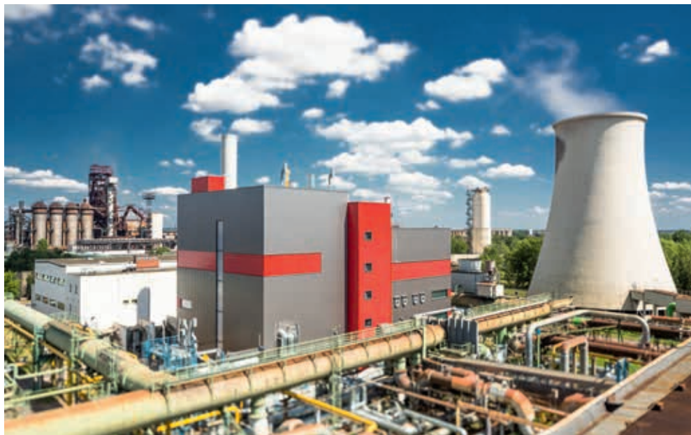
Les effluents gazeux d'ArcelorMittal Eisenhüttenstadt sont acheminés (de gauche à droite) par les canalisations vertes vers les chaudières de la centrale électrique voisine.
