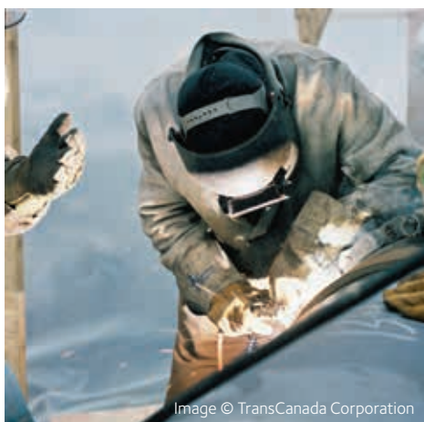
ArcelorMittal contrôle avec précision la composition chimique des aciers pour tubes énergie pour garantir une bonne soudabilité et ténacité.
