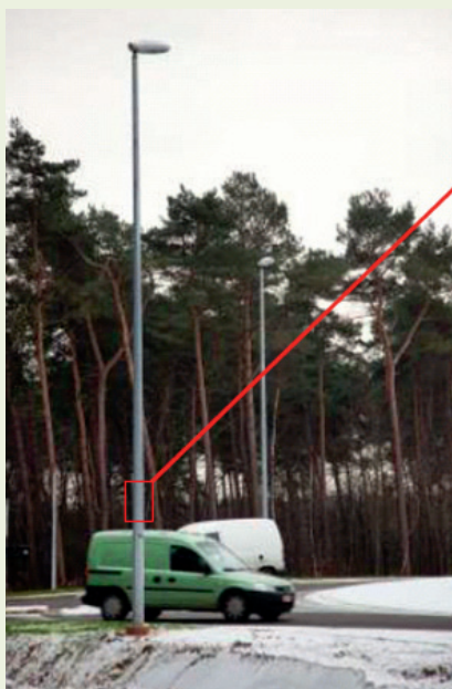
Le ZIPpole® est conçu pour s'ouvrir comme un « zip » en cas d'impact.
