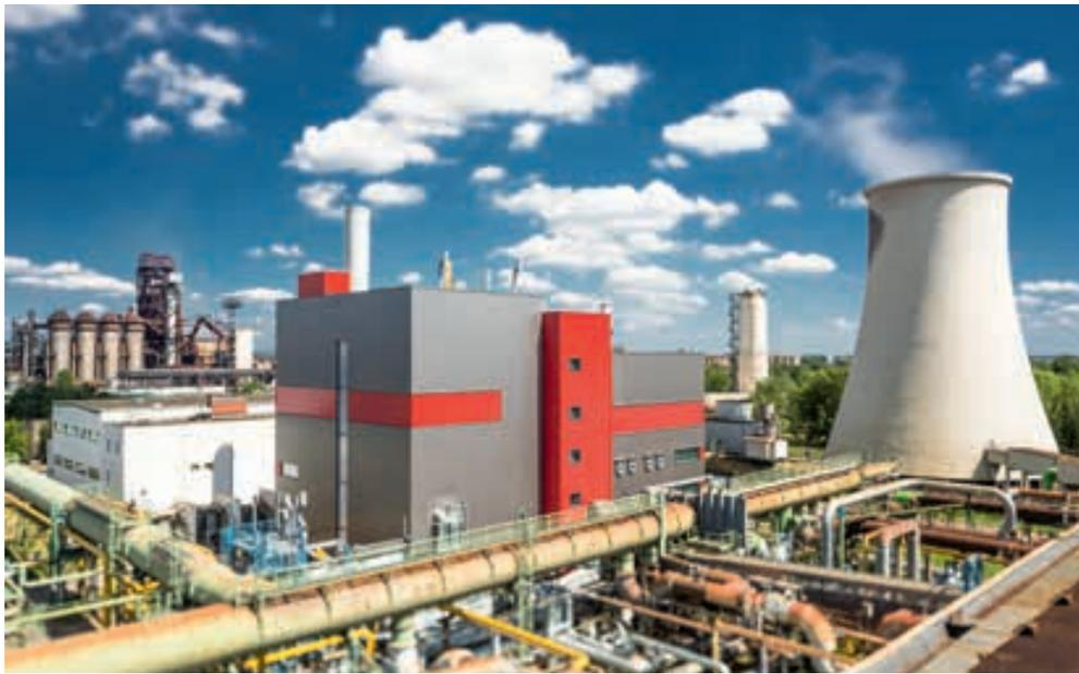
I gas residui del flusso di ArcelorMittal Eisenhüttenstadt (da sinistra a destra) passano attraverso i condotti verdi per giungere direttamente nelle caldaie della centrale elettrica esterna.
