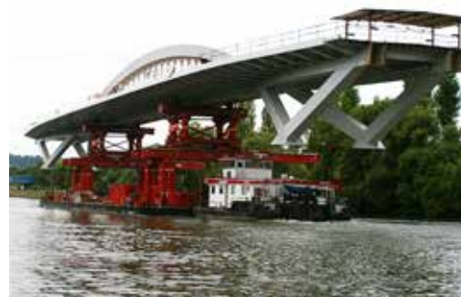
Transport van de hoofdovertopping per lichter over de Moezel.
