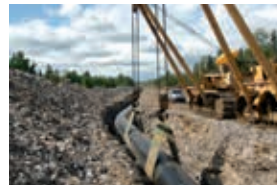
ArcelorMittal maakt zich op om cruciale nieuwe energiepipleidingen te ondersteunen.
