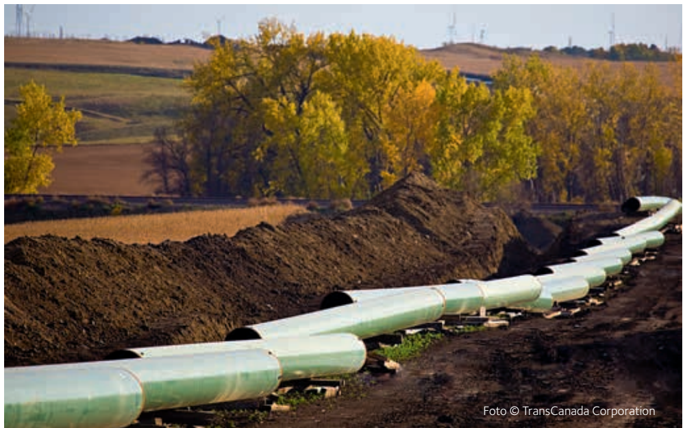
Buizen voor TransCanada's Keystone-oliepijplijn die klaarliggen voor de aanleg.
