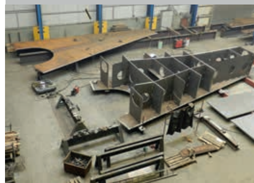
Vervaardiging van de brugconstructie in de Poncin-ateliers in Ocquier.
