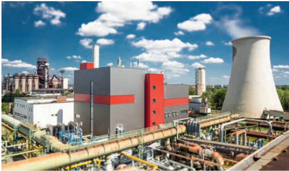
ArcelorMittal Eisenhüttenstadt leidt energierijke gassen via de groene pijpleidingen (van links naar rechts) rechtstreeks naar de reservoirs van de externe elektriciteitscentrale.
